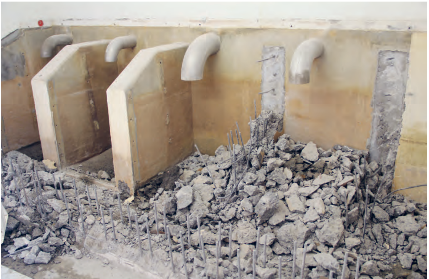
Umbau Quellsammelschacht Kaufmannshof - Einbau Quellwasserverwurf: Die bestehenden Betonbecken werden ausgebrochen.
