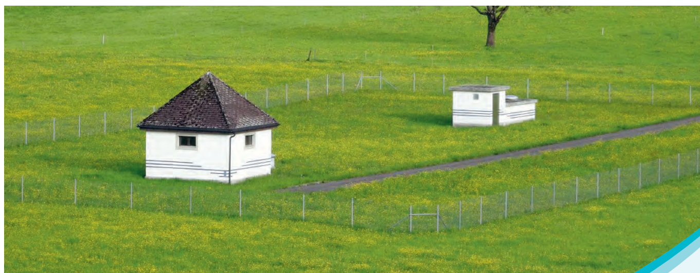
Grundwasserpumpwerke Grossfeld: Grossfeld I (links) und Grossfeld II (rechts).
