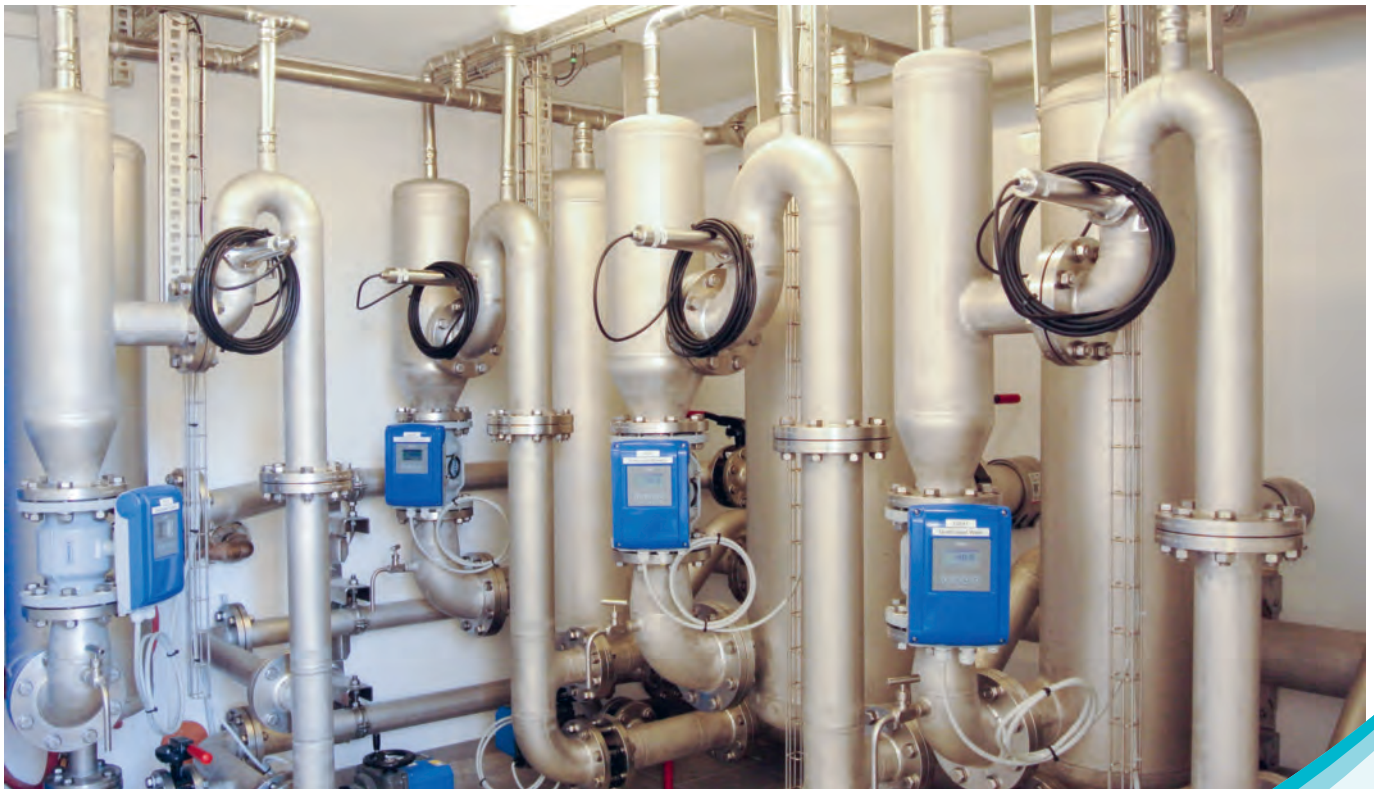
Die Zulaufmenge und die Trübung werden elektronisch gemessen. Wird ein Trübungswert überschritten, wird das Wasser automatisch verworfen. Eine UV-Anlage sorgt für eine optimale Entkeimung.
