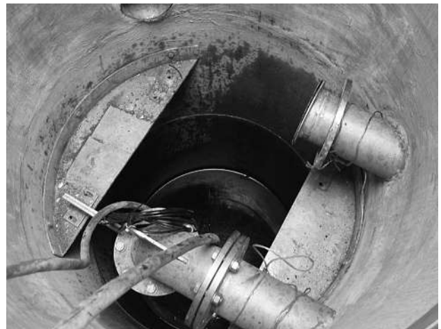
Blick in den Pumpschacht
