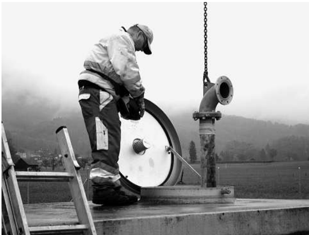
Ausbau der alten Pumpe 3
