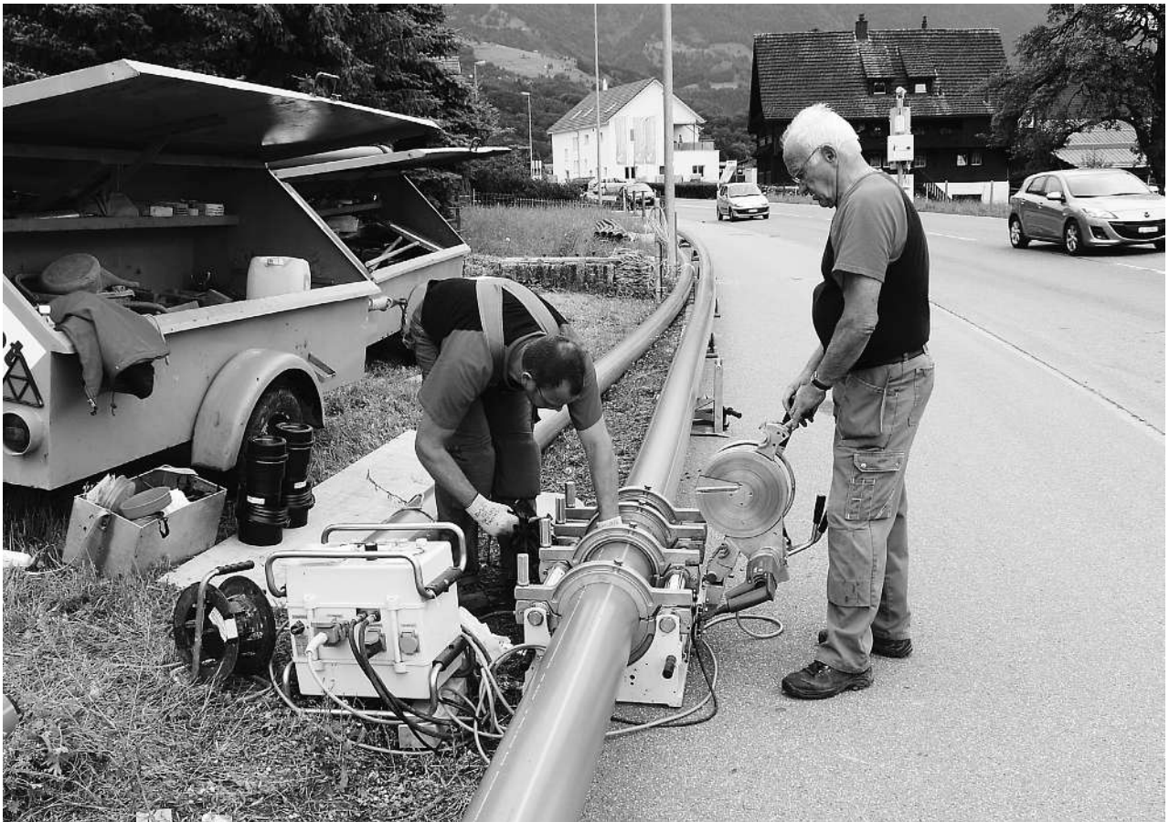
Schweissen von Hauptleitungen
