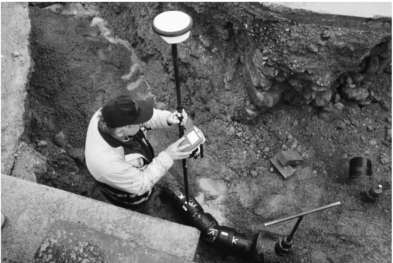
Präzision beim Leitungsbau
