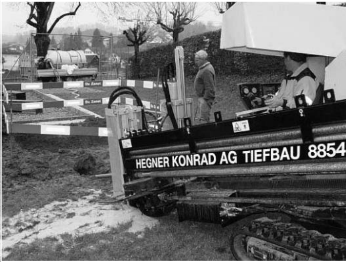
Bohrmaschine beim Schulhaus Hältli
