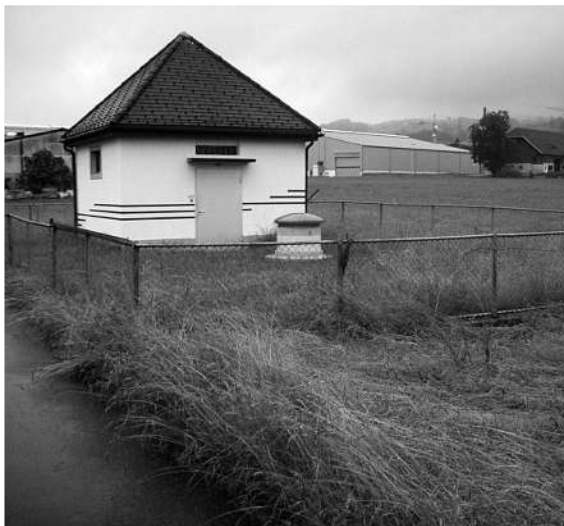
Alte Einfriedung um Pumpwerk 1
