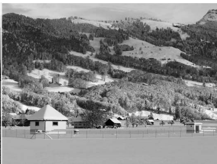
Neue Einfriedung um Pumpwerk 1 und Pumpwerk 2
