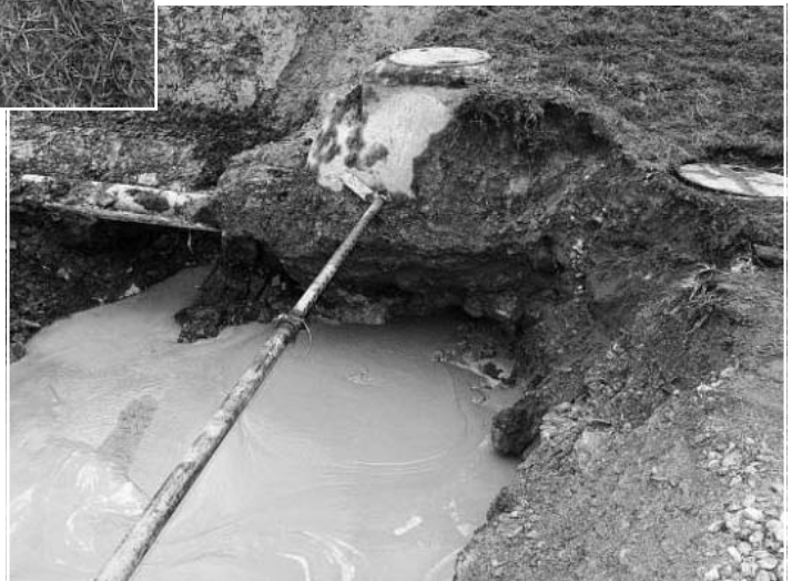
Bohrloch beim Schulhaus Hauswiese
